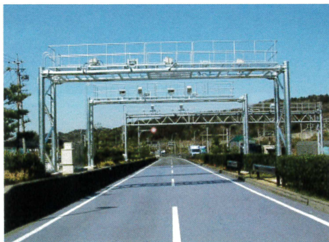
車両重量自動計測装置による計測
