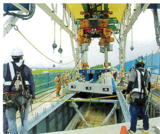
プレキャストPC床版の架設
