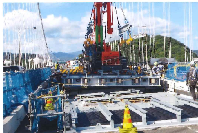
④(新)大型伸縮装置設置作業状況
