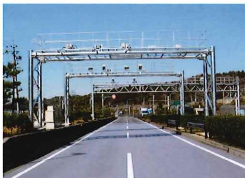
車両重量自動計測装置による計測
