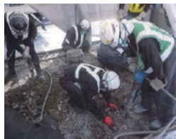
床版の部分打替状況（阪神高速14号松原線）
