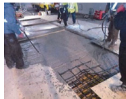
床版の部分打替状況（阪神高速14号松原線）
